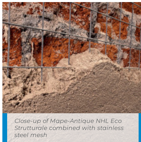
Applying a second layer of Mape-Antique NHL Eco Strutturale
