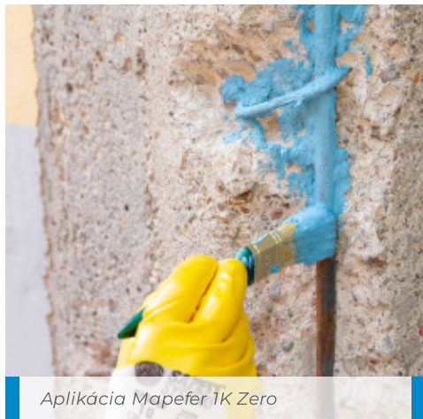
Mapefer 1K Zero aplikovaný na oceli mostnej konštrukcie
