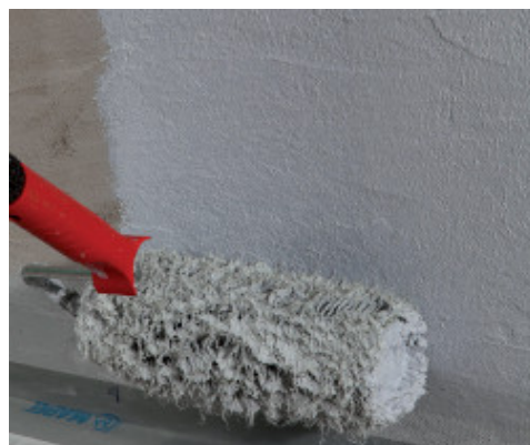
Aplikácia Mapegum WPS s použitím valčeka
