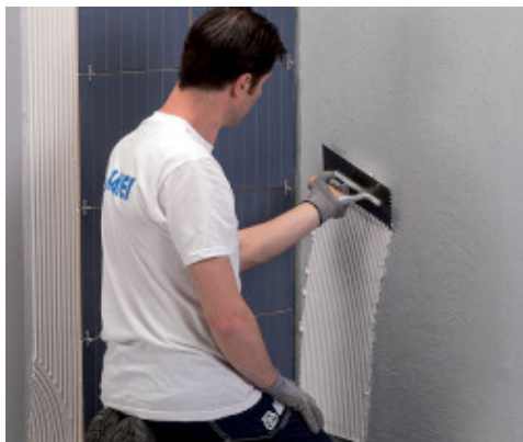
Inštalácia obkladových prvkov s použitím lepidla Keraflex Maxi SI
