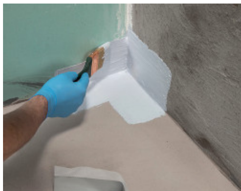
Inštalácia vnútorného rohu 90° Mapeband PE 120 s použitím Mapegum WPS
