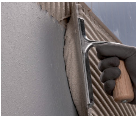
Inštalácia obkladových prvkov s použitím lepidla Ultramastic III
