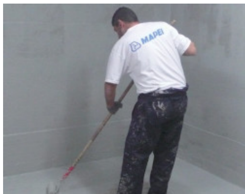
Mapelastick Foundation aplikovaný s valčekom na podlahe proti negatívnej tlakovej vode
