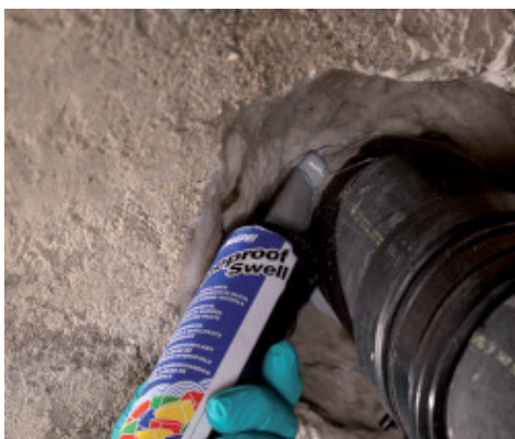
Utesnenie potrubia v stene s použitím Mapeproof Swell
