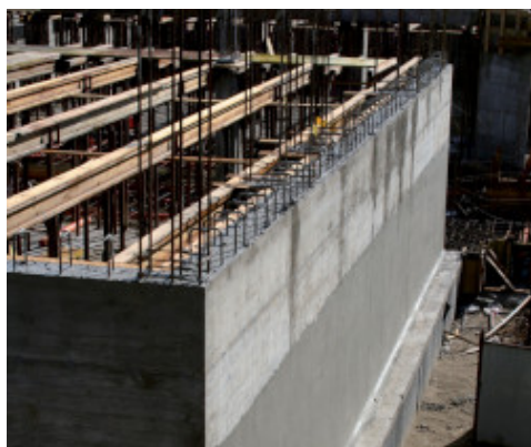
Vodotesné ošetrenie oporných stien s použitím Mapelastick Foundation
