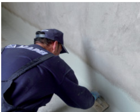
Mapelastick Foundation aplikovaný s použitím stierky proti negatívnej tlakovej vode
