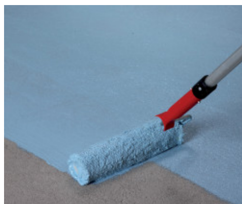
Aplikácia prvej vrstvy Mapelastix Aquadefense na cementovom poteri
