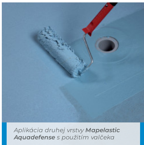
Aplikácia Mapelastix Aquadefense na odtokový vpust Drain Vertical
