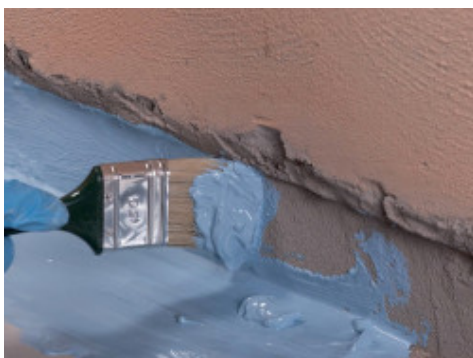
Aplikácia vrstvy Mapelastix Aquadefense s použitím štetca v styku steny a podlahy pred inštaláciou pásky Mapeband
