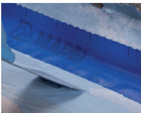
Inštalácia pásky Mapeband v styku vodorovnej a zvislej plochy do prvej vrstvy Mapelastix Aquadefense
