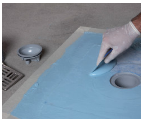
Aplikácia Mapelastix Aquadefense na odtokový vpust Drain Vertical
