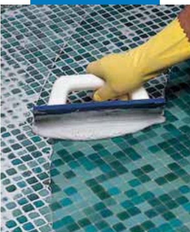
Škárovanie sklenenej mozaiky použitím škárovacej malty Keracolor FF zmiešanej s tekutou prísadou Fugolastic
