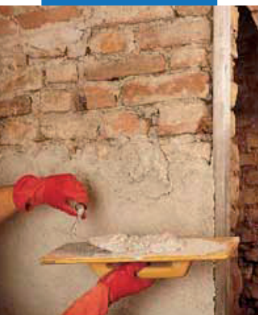
Aplikácia odvlhčovacej omietky Mape-Antique LC
