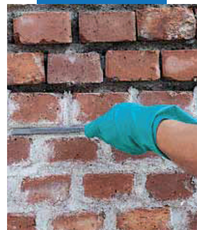
Výplň škár v tehlovom murive s použitím Mape-Antique MC
