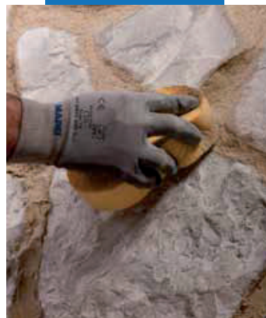
Dokončenie, úprava povrchu škáry hubkou
