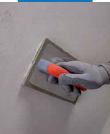
Dokončenie povrchu Mape-Antique FC Civil navlhčeným špongiovým hladidlom
