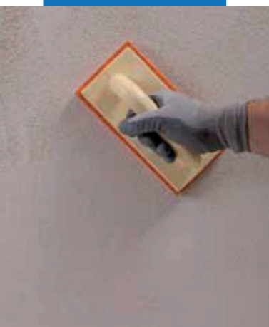
Dokončenie povrchu Mape-Antique FC Grosso navlhčeným špongiovým hladidlom
