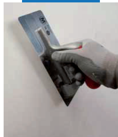
Aplikácia druhej vrstvy Mape-Antique FC Ultrafine
