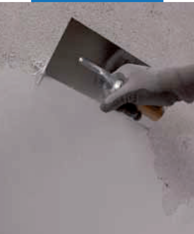
Aplikácia prvej vrstvy Mape-Antique FC Ultrafine
