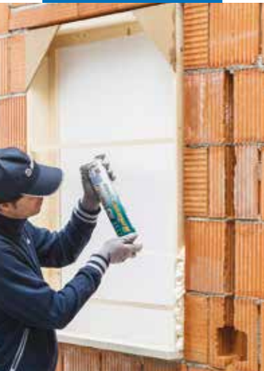
Výplň dutiny medzi okenným rámom a stenou
