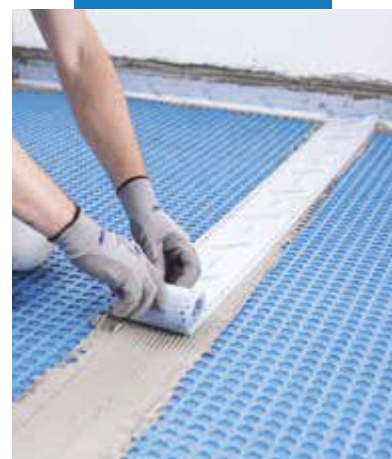
Zaizolovanie škáry vzniknutej medzi príľahlými pásmi s použitím pásky Mapeband Easy nalepenej do Mapeguard WP Adhesive
