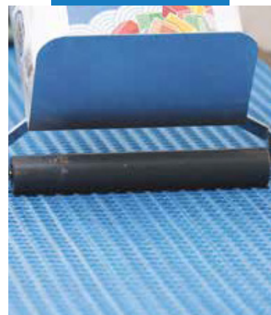
Zatlačenie Mapeguard UM 35
