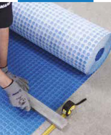
Narezanie Mapeguard UM 35
