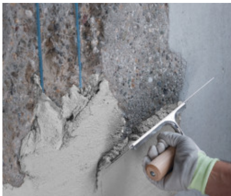
Aplikácia malty Planitop Rasa & Ripara Zero stierkou
