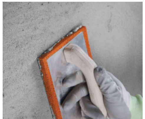
Zahľadenie povrchu Planitop Rasa & Ripara Zero
