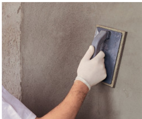
Konečná úprava Planitop 540 použitím hubky
