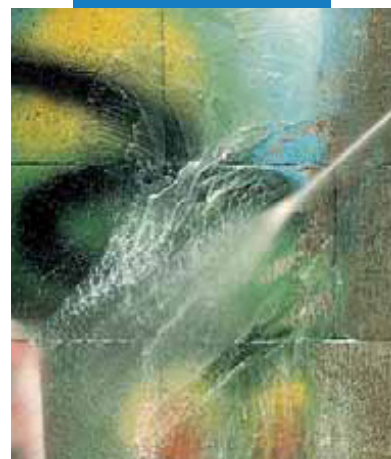
Čistenie vysokotlakovým vodným lúčom
