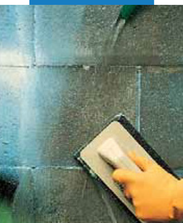
Odstránenie grafity abrazívnym nástavcom
